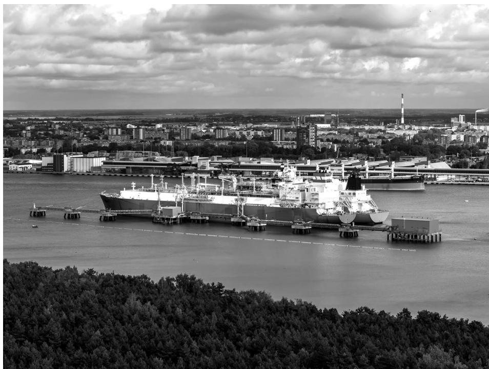
Terminal importowy Independence w Kłajpedzie
