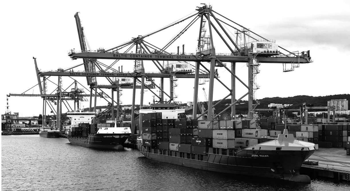
Bałtycki Terminal Kontenerowy w Gdyni
