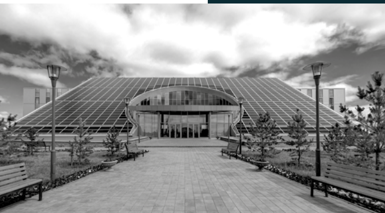
Panele słoneczne na dachu budynku w Astanie, Kazachstan
