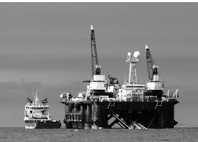
Budowa gazociągu Baltic Pipe
